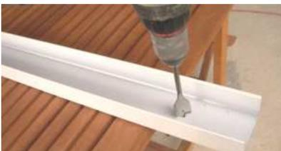
Faire un avant trou diamètre 4 mm, puis percer  $\varnothing$  25 mm dans l'axe du capot avec la mèche fournie, et ébavurer
