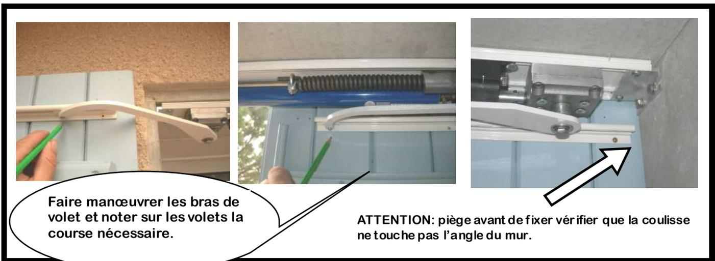
Fixer les coulisses sur les volets (dans le cas de volets PVC, il est conseillé de traverser ou de mettre une entretoise à l'intérieur des volets)
