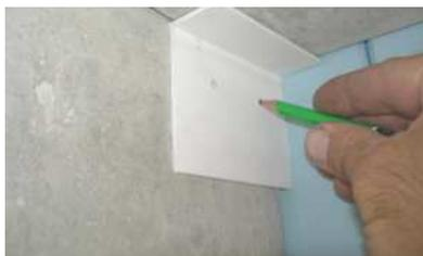
Avec le même gabarit tracer l'axe de fixation des coulisses sur les volets.
