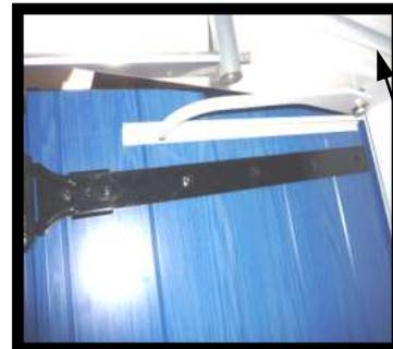
Fixer la coulisse du bras supplémentaire derrière le caisson du pratic volet laisser 5 mm de jeu entre la coulisse et le caisson.
